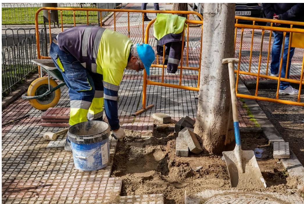
Operarios reparando las aceras
