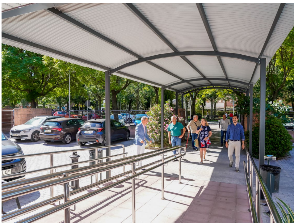
Una de las actuaciones ha permitido instalar nueva pérgola
