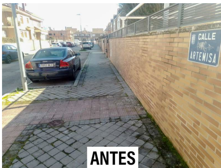
Antes y después del acerado de la Calle Artemisa (Fresnos)
