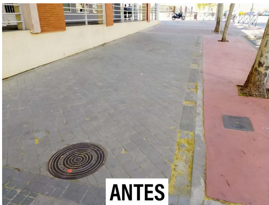
Antes y después del acerado de la avenida Madrid (Juncal)
