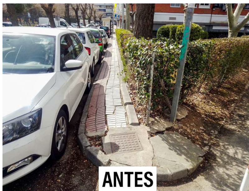
Antes y después en la calle Brújula (Parque de Cataluña)
