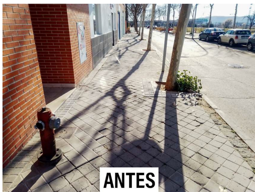
Antes y después de la acera de la calle Urano (Fresnos)
