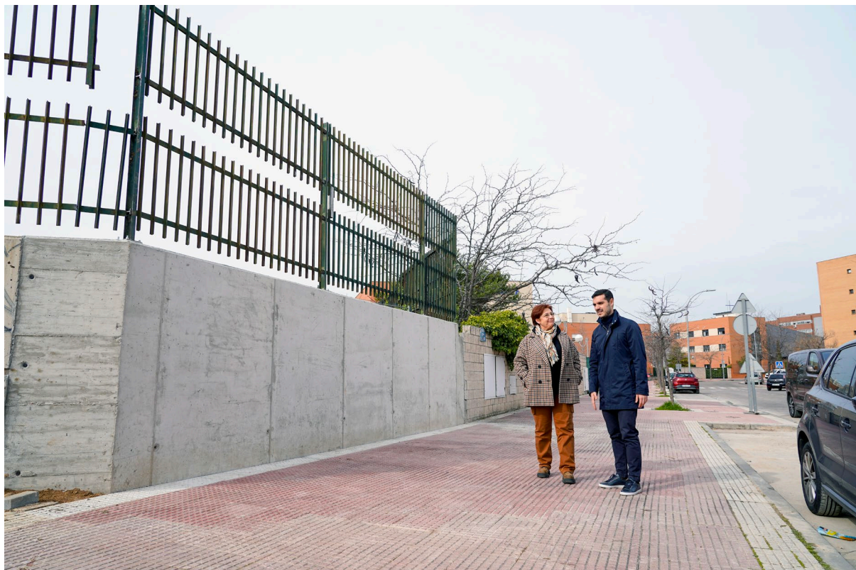
El alcalde, Alejandro Navarro Prieto, supervisó el resultado de los trabajos junto a la directora del instituto Victoria Kent, Pilar Álvarez
