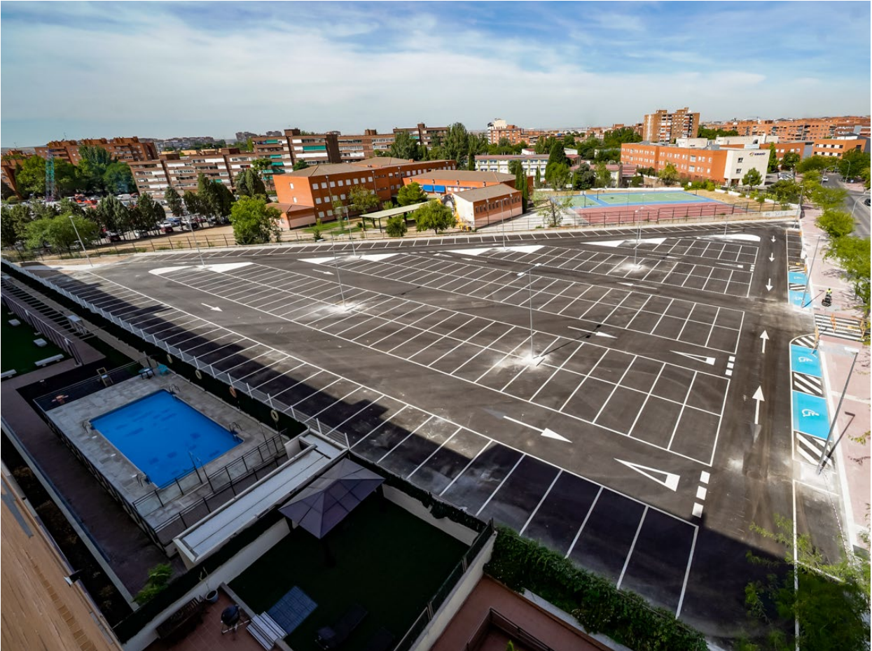
Nuevo aparcamiento en superficie gratuito de 231 plazas en la calle Francia
