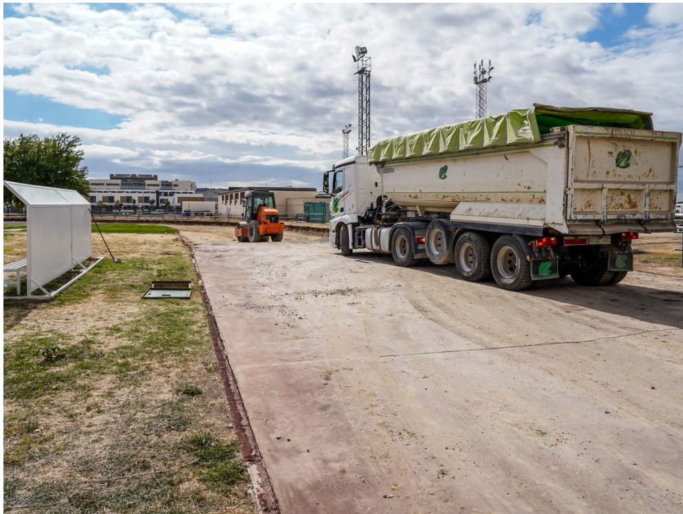
Iniciadas las obras de la nueva pista de atletismo
